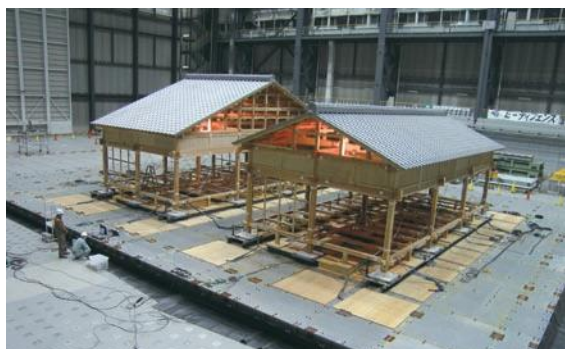
写真4 平成18年度の伝統構法木造建物試験体 (屋根付き試験体)
