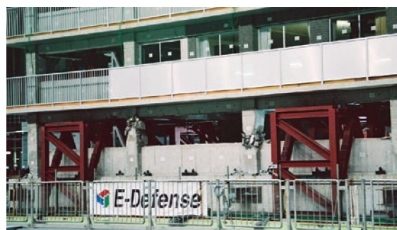
最終損傷状況 (X 1 通り)
