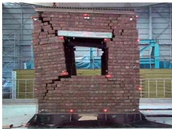
写真1 開口部四隅から広がる亀裂
