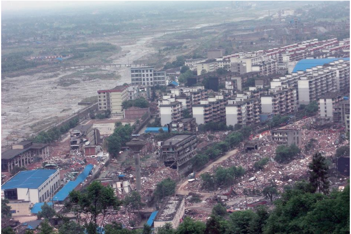
写真4 漢旺鎮の被害状況。町の北端にある山の中腹の慈航観から撮影。
