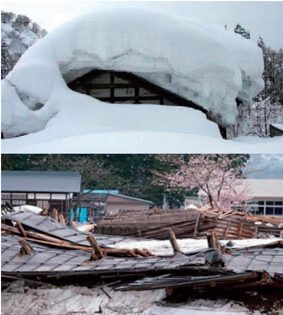
写真2 豪雪に覆われた家、2005年2月(上)、雪の重みで倒壊、4月末(下)
