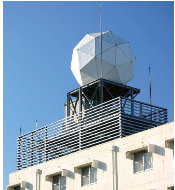
写真1 神奈川県海老名市に設置したMPレーダ
