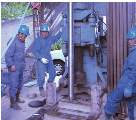
写真1 富士第6火山観測施設の観測井への地震計・傾斜計の設置
