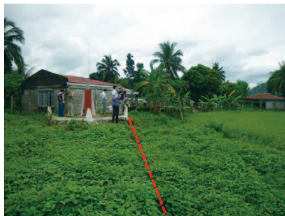
写真5 フィリピン断層(ルソン島ガバルドン断層)と、その上に建つ典型的なブロック組石造住宅
