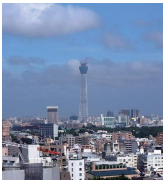
写真3 建設中の東京スカイツリー
