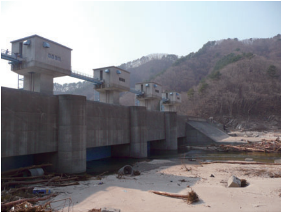
写真11 海側から見た普代水門。
