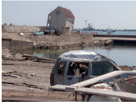
写真5 津波と液状化の被害を受けた鹿島港の魚釣園。
