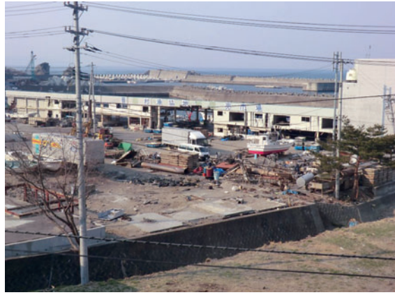
写真14 大田名部防潮堤から見た海側の漁港の様子。大きな損傷を受けている。
