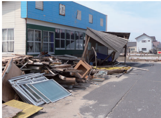
写真6 津波の被害を受けた京知釜海水浴場。
