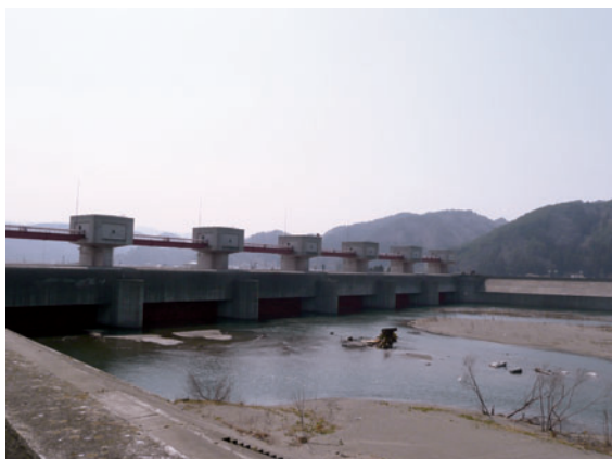
写真7 海側から見た小本水門。この左側手前に防潮堤(写真10)がある。
