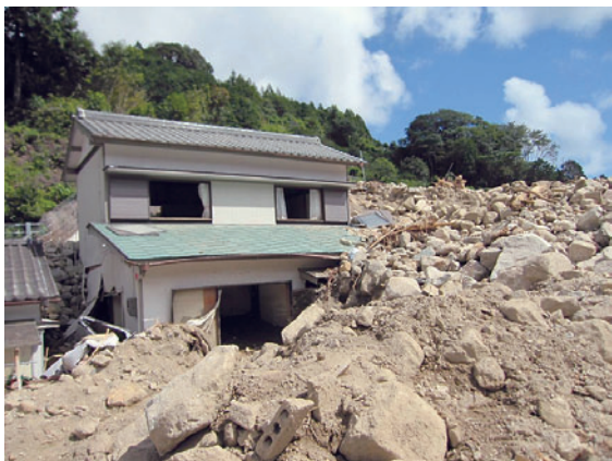
写真1 那智勝浦町市野々地区の土石流災害
