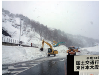
国道112号の雪崩災害対策の様子
