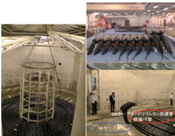
写真3 積み込み後の船内写真。左) ケーブルタンク全景。敷設時は天井からケーブルが繰り出される。右上) ケーブルタンク上のデッキに収納された観測装置。手前12台が鹿嶋市側から設置するもの、奥10台が南房総市側から設置するもの。右下) ケーブルタンクに巻き取られている海底ケーブル。
