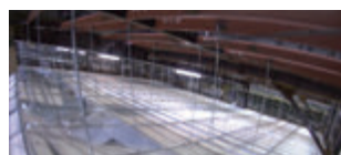
図2 仙台波50%(2回目)での未対策天井脱落被害の再現
