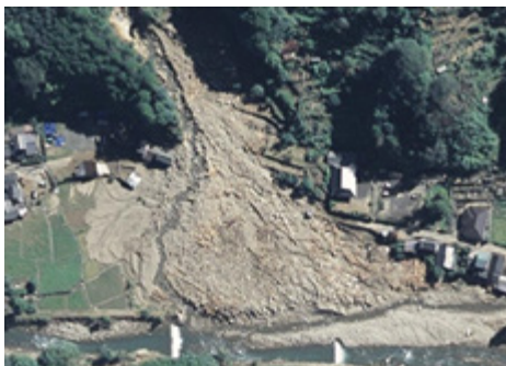
写真1 谷底平野に押し寄せた土石流
