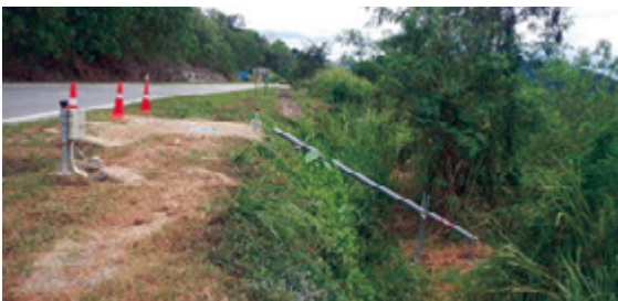
写真2 モニタリング斜面 (変位、地下水計測)
