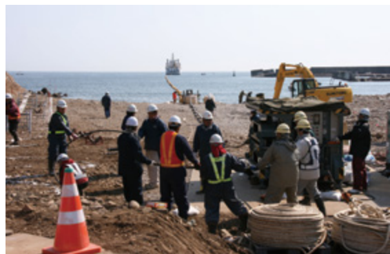
写真2 沖合いの敷設船から海底ケーブルを引き揚げている様子
