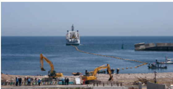
写真1 宮古市中の浜で実施した海底ケーブル陸揚げ作業の様子
