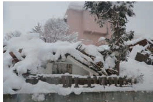
図4 空き家の倒壊(新潟県1月15日)
