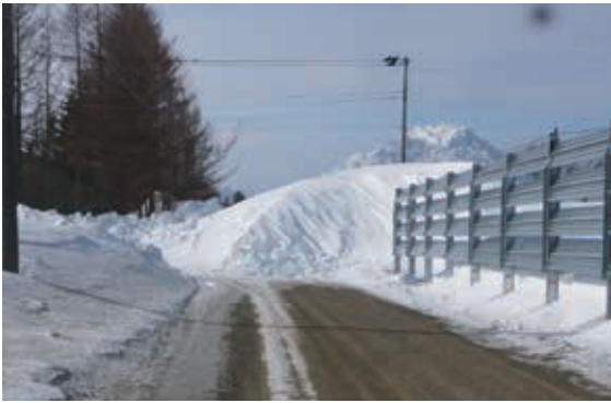
図3 中標津町西養老牛付近の町道に形成された吹きだまり。2月6日撮影。卓越風の向きは右から左。
