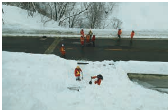
図4 国道112号月山道路での現地調査(雪崩発生地点)
