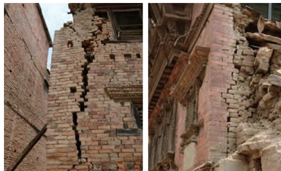
写真6 RC枠組を持たない構造（Sanhku）
