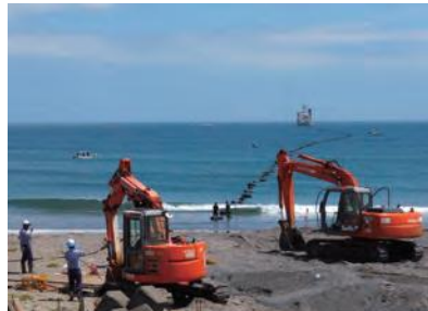
写真3 ケーブル陸揚げ作業の様子
