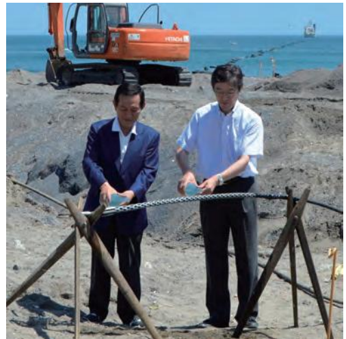
写真1 工事の安全祈願にご参加いただいた鹿嶋市の錦織孝一市長 (左) と防災科研の米倉実理事
