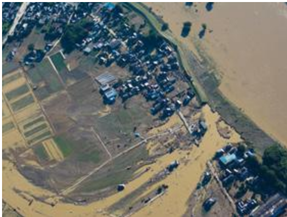
写真1 上三坂地区決壊地点の様子
