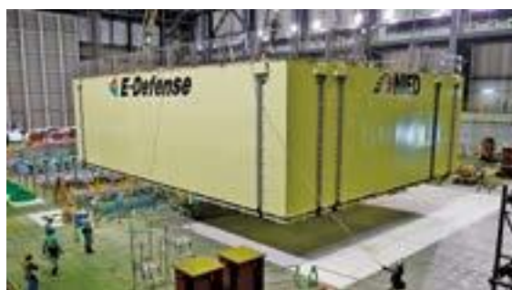
写真2 E-ディフェンスの更新工事
