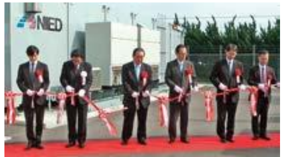
写真1 南房総陸上局テープカットの様子
