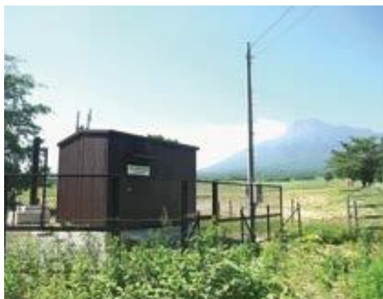
写真1 岩手山の火山観測施設
