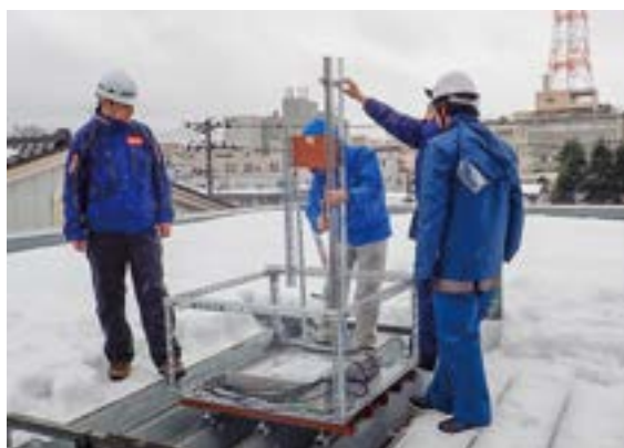
写真1 店舗屋上へのセンサー設置の様子
