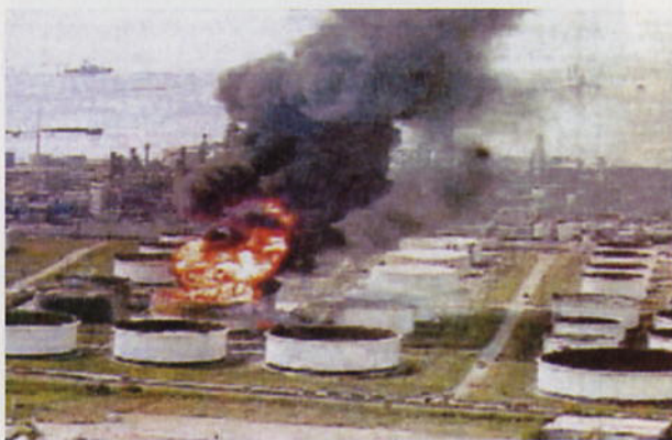
図1 タンク被害（トルコ地震） ※Bogazici University HPより引用
