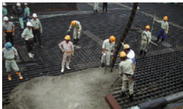
第1回コンクリート打設の状況（平成12年6月20日）
