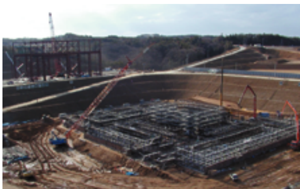
震動台基礎建設状況（平成13年1月10日）
