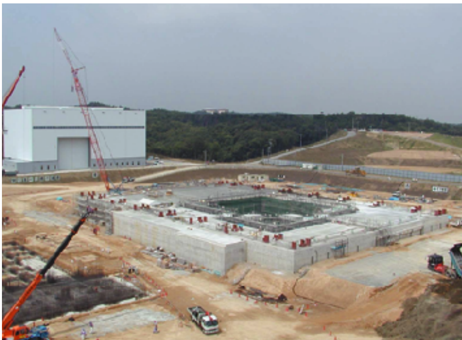
震動台基礎コンクリート打設が完了した状況（平成13年7月4日）
