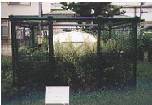
土間コン打設前の状況
