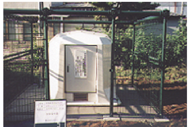
土間コン打設後の状況
