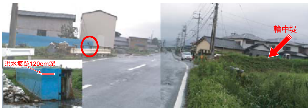
写真4 十六町を守る輪中堤の道路切り通し部、洪水時には青色の陸門を道路上に移動させて輪中堤を閉じる。
