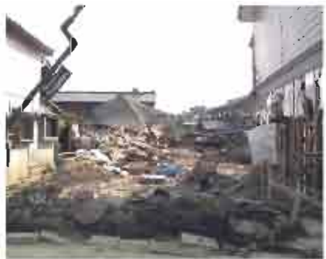
写真1 新潟県中之島町中之島の刈谷田川破堤地点付近の倒壊家屋
