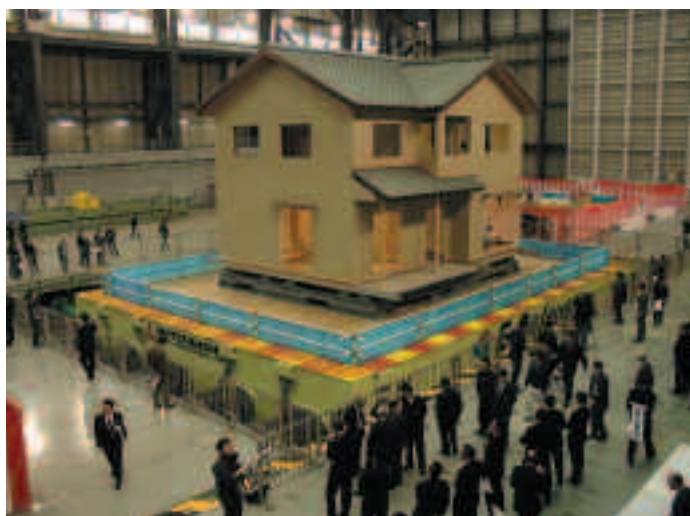
写真1 披露式時震動台に設置された2階建て木造住宅
