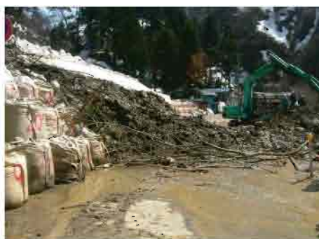
図3 長岡市濁沢町で発生した土砂崩れ
