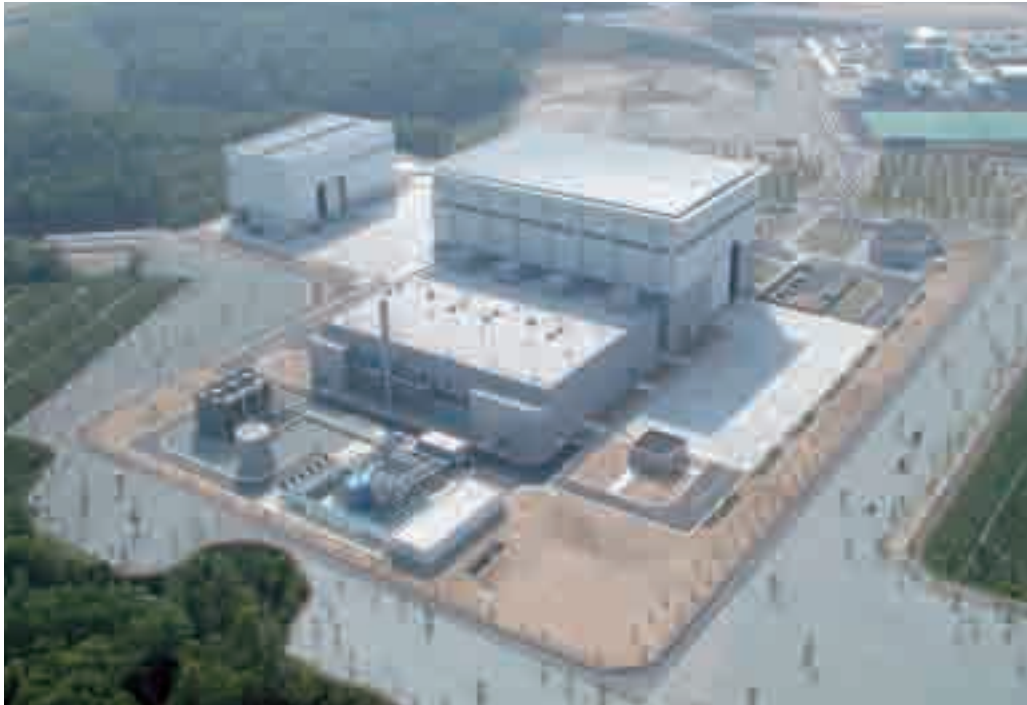
2005年1月に完成した「Eーディフェンス」
