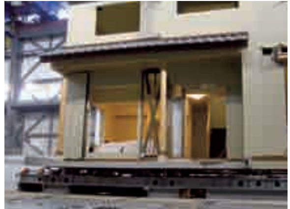
図2 J R 鷹取 1 回目の破損
