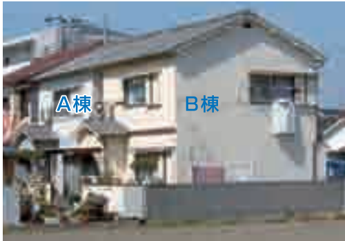
図6 移築される明石市の住宅2棟
