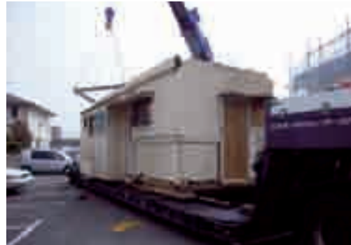
図7 移築作業
