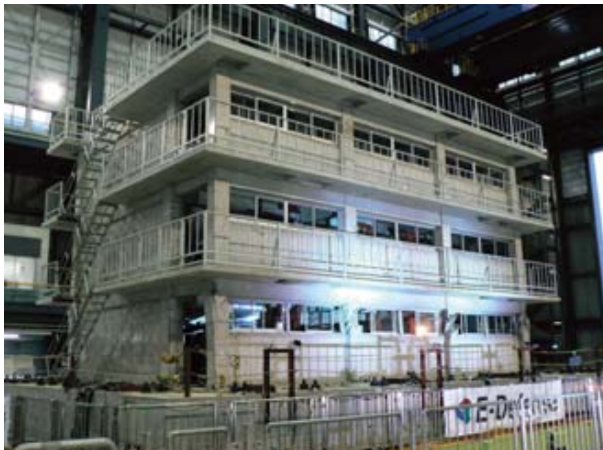
写真2 試験体全景（10月2日の実験後）
