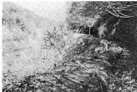
写真 6 山崩れのため、水の潤れた農業用水路。崖ぶちを通る路は、幅 40~50 cm、谷の斜面は、80度くらいの勾配で、川床まで 30~40 m ほど落ち込んでいる（赤砂川右岸）。
