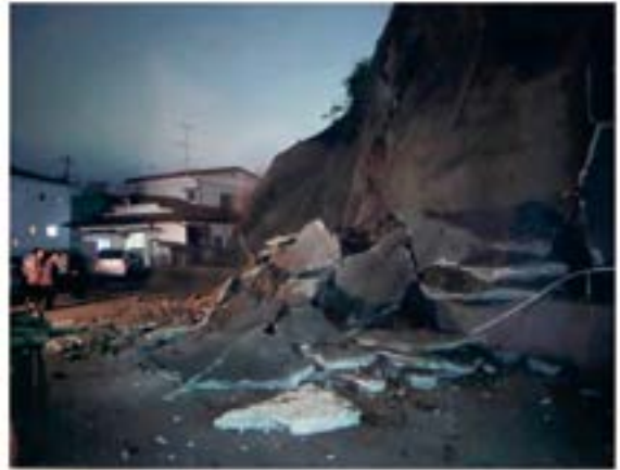
写真2 塩竈市芦畔町の法面崩壊現場 (3月20日18:21 近隣住民撮影)
