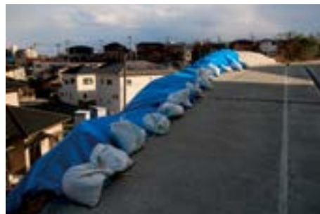
写真5 法面上部:コンクリートでの補強の状況 (3月22日撮影)
