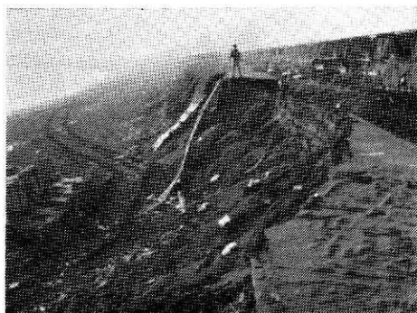
写真 2 茅ヶ崎海岸サイメリング道路の崩落現場
