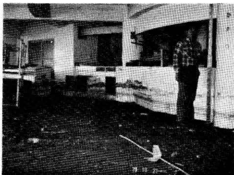
写真1 藤沢市湘南海岸公園内東急レストハウスに残った水位痕跡
