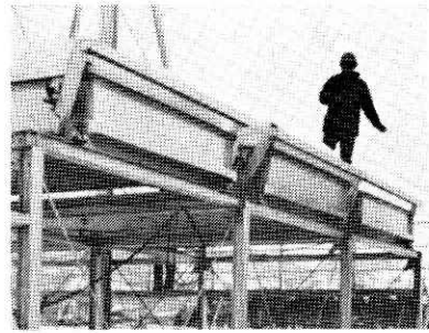
写真3 着脱式の雪止め
