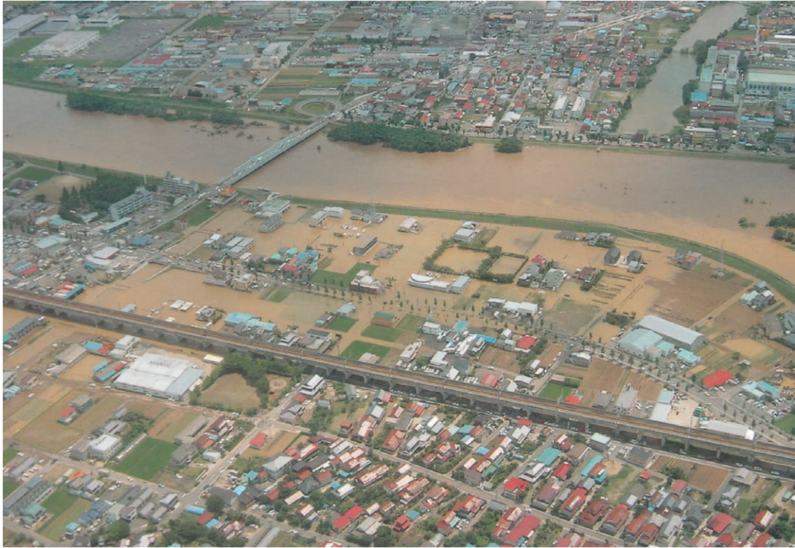
口絵 1 台風 6 号による郡山市の氾濫状況 (1) (郡山市河川課提供) Fig. 1 Flood water caused by Typhoon No. 6 (1).
