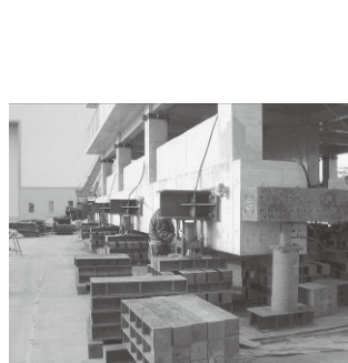
写真 3.3 ジャッキアップ Photo 3.3 Jacking up.
