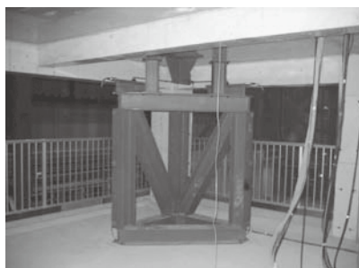
写真 4.1 層間変位計測用鉄骨計測フレーム Photo 4.1 Steel frame for measurement of story drift.
