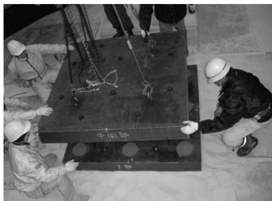
写真2.9 フーチングの設置 Photo 2.9 Installation of the footing.
