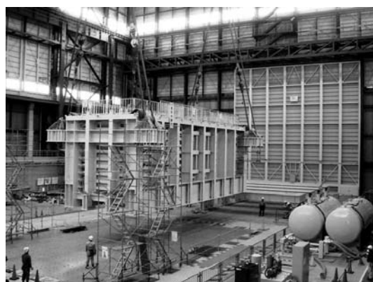
写真3.8 試験体の震動台上への設置
