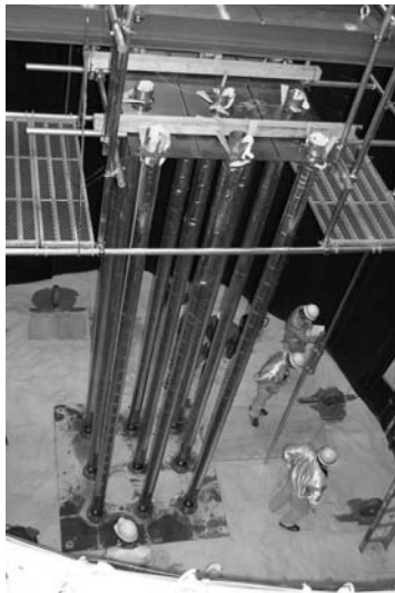
写真2.4 杭基礎 Photo 2.4 Pile foundation.
