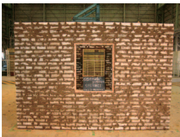
(c) 窓枠完成
