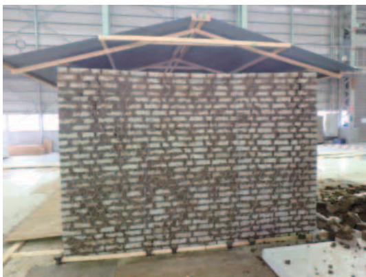
(b) ジャケッティング補強(背面)
