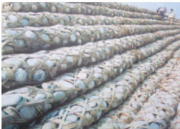
(a) 河川工事の様子 (中国四川省都江堰において説明案内板を撮影)
