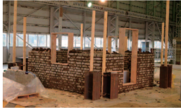
(b) 出入口枠設置状況
