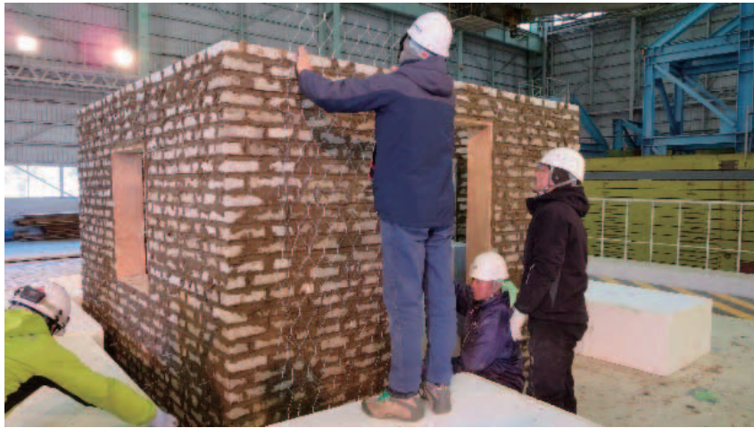
(c) 壁への設置状況
