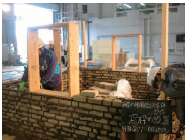
(b) 窓枠設置状況
