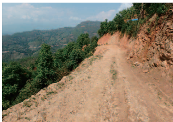
(b) 掘削しただけの崩壊しやすい道路構造
