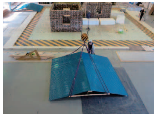
(d) 屋根完成および吊り上げ
