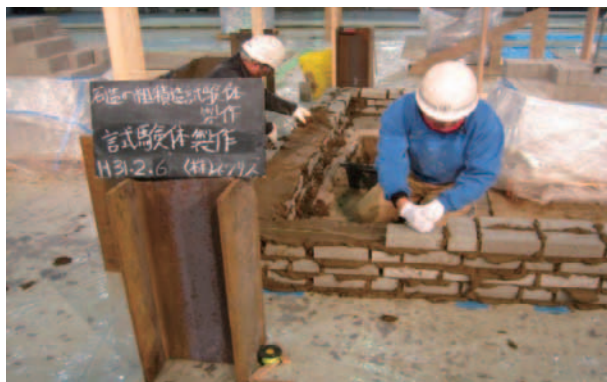
(a) 組積の状況
