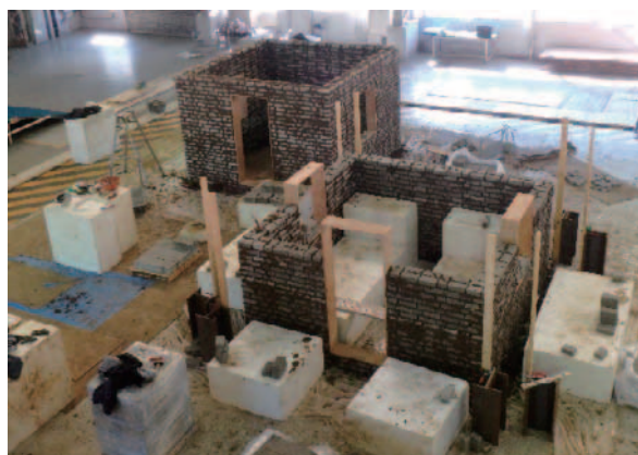
(b) 2棟目組積の状況
