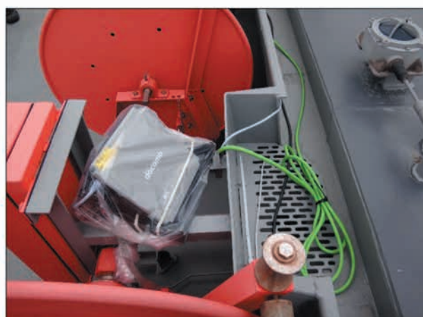
図 18 アンテナ設置状況 Fig. 18 Antenna installation status.
