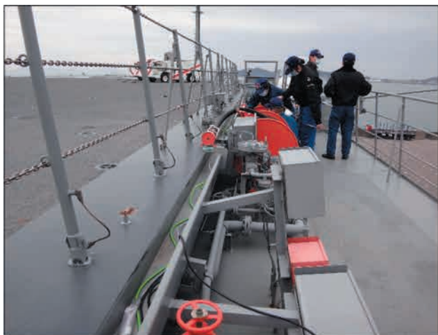
通信試験準備の様子(機器設置)①
