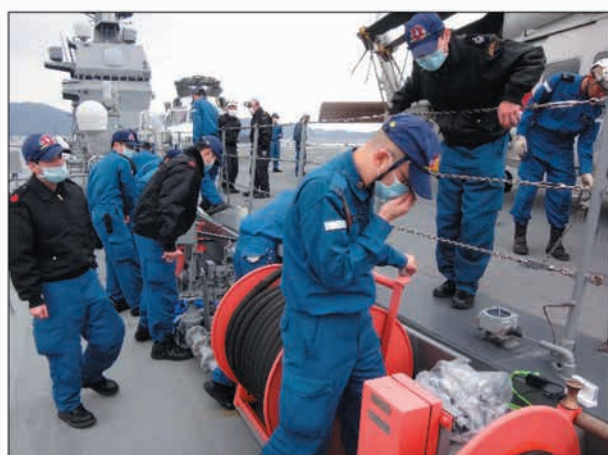
図 17 配線作業状況 Fig. 17 Wiring status.
