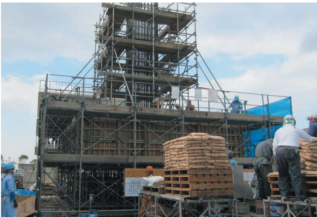
写真 5.1 C1-6 橋脚の製作状況 Photo 5.1 C1-6 column reinforcing bar assembly.
