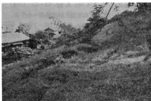
写真三 砂丘斜面における地割れ(新潟市青山水道局公舎裏山) Cracks on the slope of dune.
