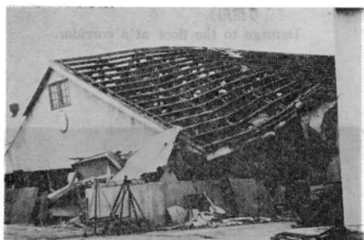
写真—8 日通倉庫の被害（中央埠頭） Damage to a wooden storehouse.
