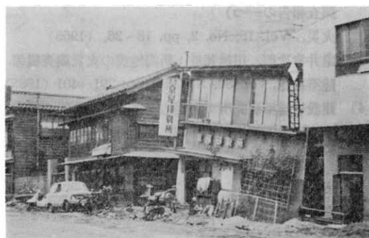
写真六 隣接建物の沈下による被害(新潟市下大川前) Damage by the sinking of an adjacent building.
