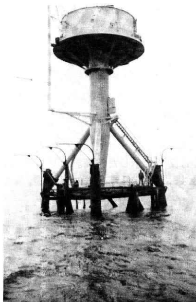
写真1 観測塔でのアレイ式波高計センサーの架台
