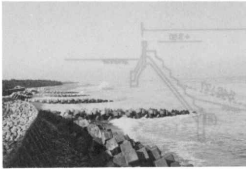
写真7 異形ブロックによる根固および突堤群突堤群の向うに小さな島のようにみえるのは離岸堤である。(富山海岸)
