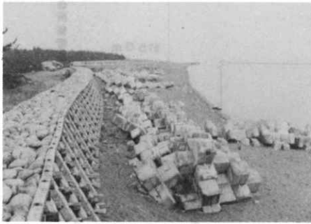
写真6 合掌杵護岸の状況
