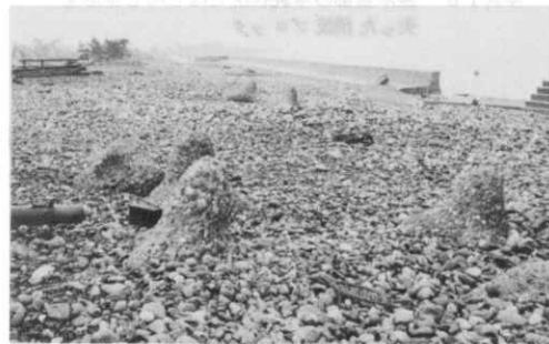
写真8 堤防背後に打上げられ残ガいをさらす消波ブロック
